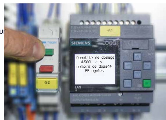
Réglage de la quantité de dosage « Vert » + 25 ml/h « Rouge » - 25 ml/h
